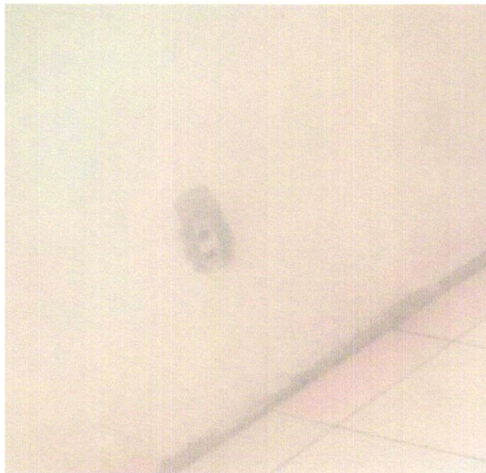
FOTO 01 – TOMADA BAIXA DE EMBUTIR ( 1 MÓDULO ), 2P + T 10A, INCLUINDO SUPORTE E PLACA – FORNECIMENTO E INSTALAÇÃO. AF 12/2015
