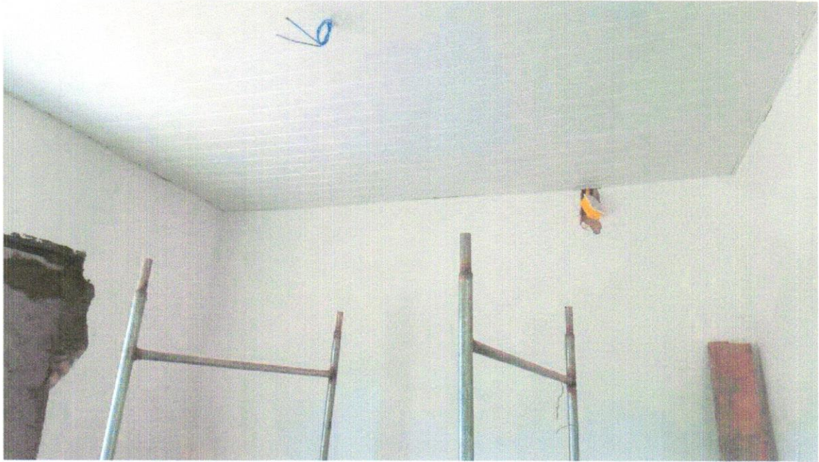
FOTO 13 -Forro de pvc, em régulas de 10 ou 20 cm, aplicado, inclusive estrutura para fixação (perfis em PVC) marca Araforros ou similar, instalado - Rev 06_10/2021
