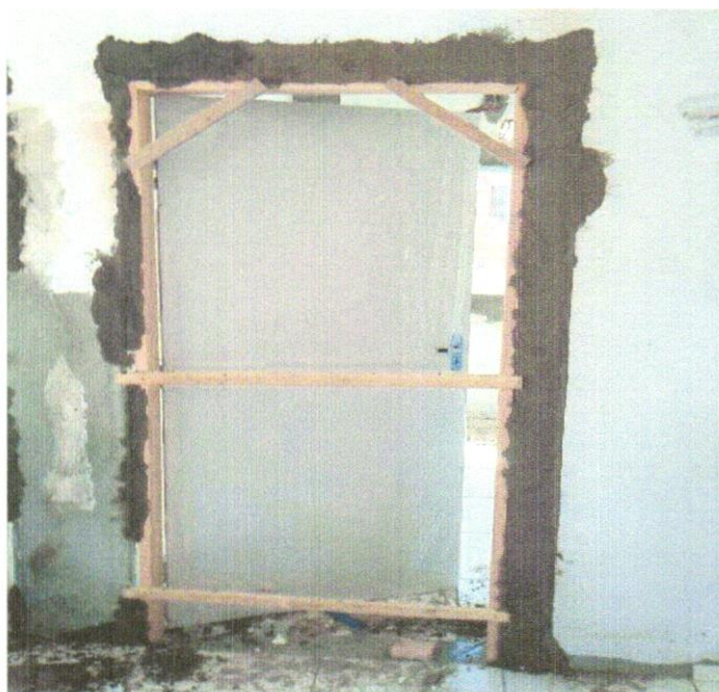
FOTO 09 – KIT DE PORTA-PRONTA DE MADEIRA EM ACABAMENTO MELANICO BRANCO, FOLHA LEVE OU MÉDIA 70X210, EXCLUSIVE FECHADURA, FIXAÇÃO COM PREENCHIMENTO PARCIAL DE ESPUMA EXPANSIVA – FORNECIMENTO E INSTALAÇÃO. AF 12/2019
